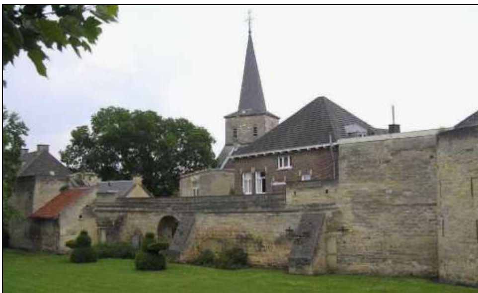
Figuur 9: Middeleeuwse stadsmuur met torens langs het huidige Halderpark.
